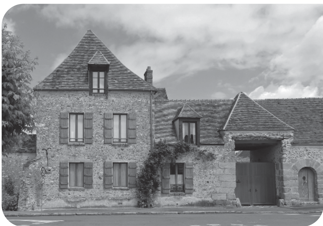
▲ Vue extérieure de la bergerie
