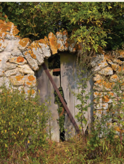
Porte dans le mur d'enceinte Sud
