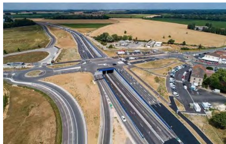
Le réaménagement du carrefour routier du Christ de Saclay. (Source : EPAPS).
