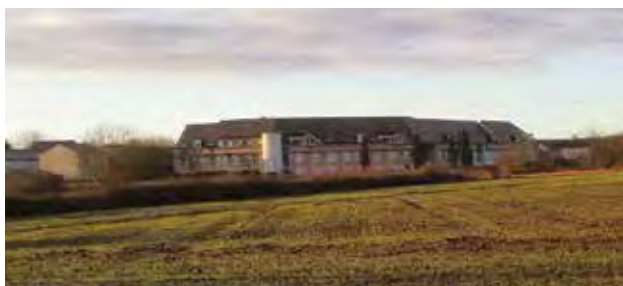
Bourg Est : des nouveaux gabarits bâtis, avec des hauteurs plus importantes, renforcent le sentiment de rupture du paysage
