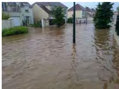
Inondation à Saclay (Val d'Albion)
