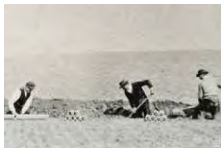
Construction des drains sur le plateau
