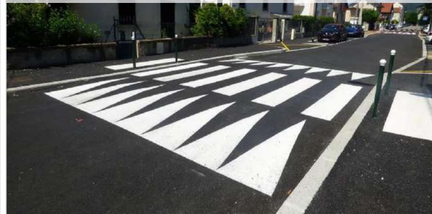
Exemple de plateau pour sécuriser une traversée piétonne
