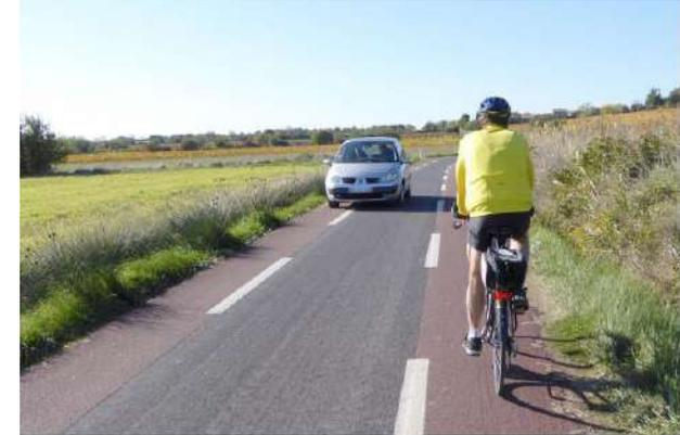
**Exemple de chaussée à voie centrale banalisée (CVCB)**
